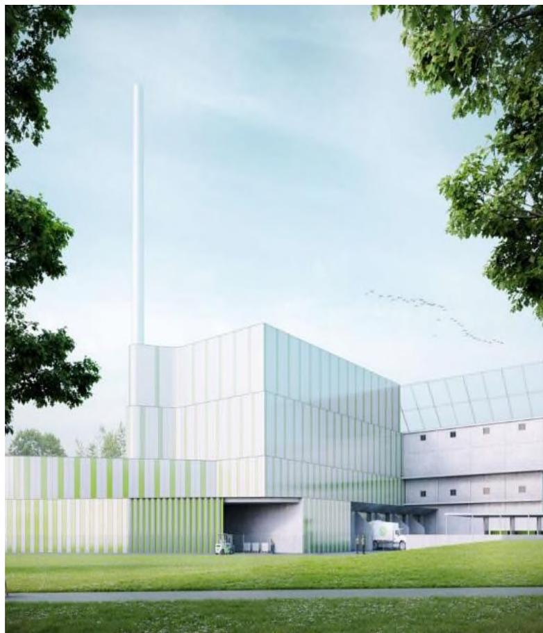
La linea FANGHI valorizzerà **65.000 tonnellate/anno di fanghi** prodotti dai depuratori del Gruppo CAP, generando: 11.120 MWh/anno di calore per il teleriscaldamento e ceneri ricche in fosforo.
