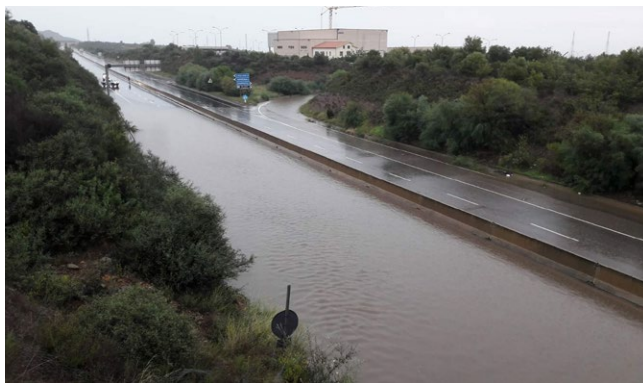
10 ottobre 2018 | Alluvione a Capoterra (CA) sulla statale 195
