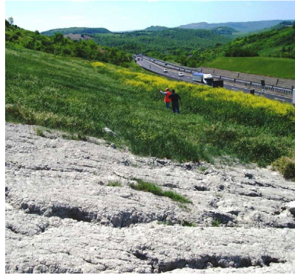
Prati Armati® lungo l'Autostrada del Sole, Fabro (TR)
