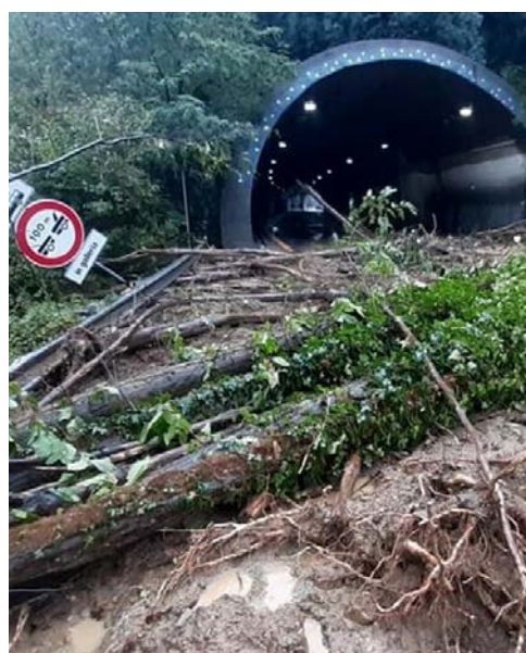
4 ottobre 2021 | Frana sull'A26 dovuta alle forti piogge
