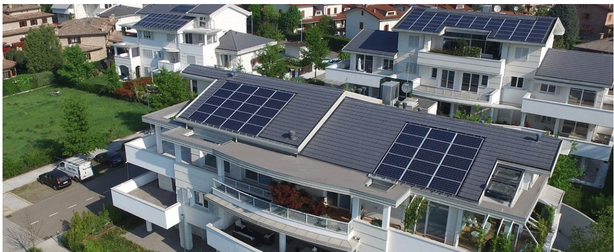
Ecovillaggio Montale, Modena
